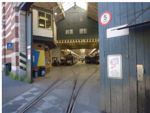
途中で路面電車のメンテナンス基地を発見!
