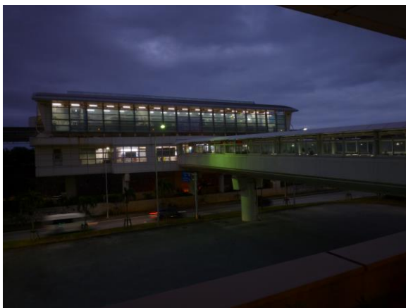
すっかり、外は暗くなっています。
