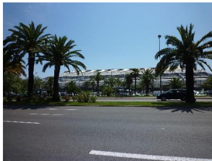
空港の外観写真
