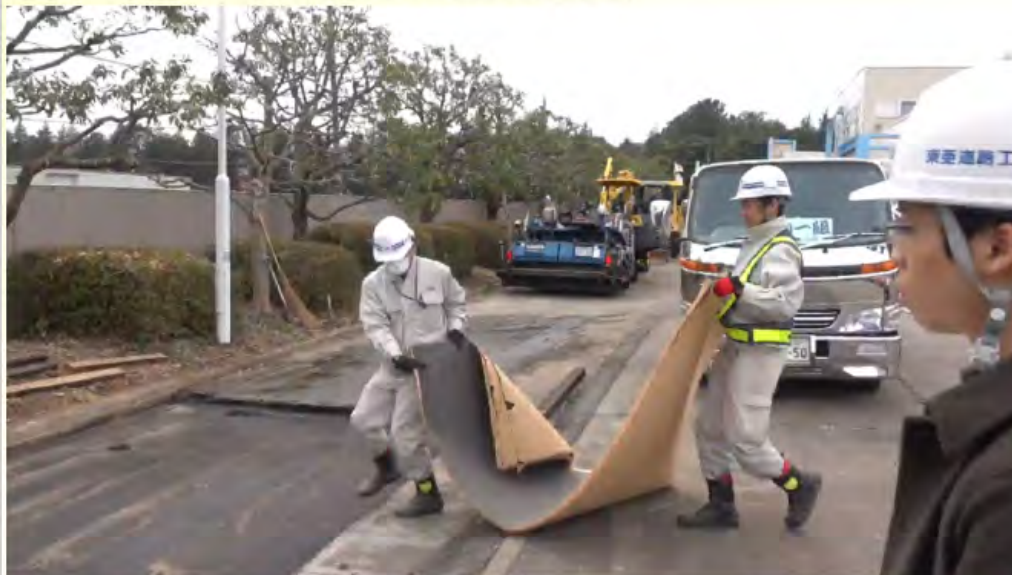
舗装工事の様子
